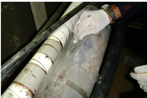
1. マンホールの中を清掃する等、補修する鉛管周囲の作業環境をできるだけ整えます。
