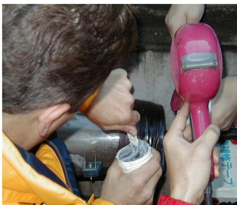
5. 完全にガス圧排除ができない場合は、短時間シーリング材エアリペーパーパテを先ず使用して完全にガス圧を止めて下さい。
