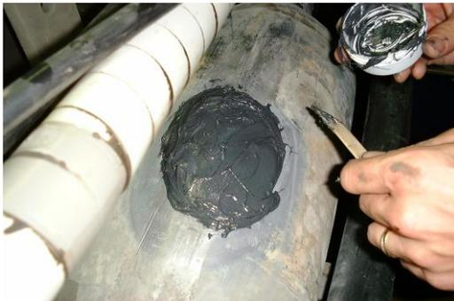
7. 上記エアリペアシール材を、清掃した表面にできるだけ手際良く肉盛りし、シール材の端はテーパ状に成形して下さい。リークポイントを中心にその周囲を半径 4～5cm、厚さ 1cm ほどを目安に肉盛りして下さい。肉盛り部を最後に手で成形して下さい。
